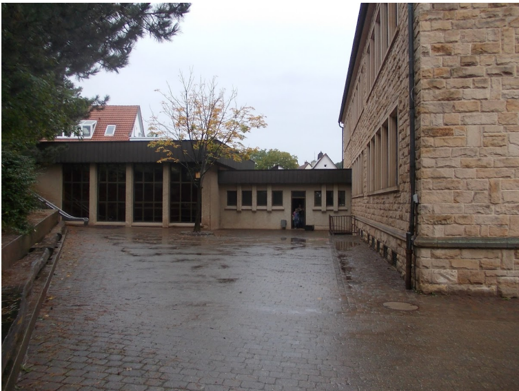
(Bestand vor Umbau)
